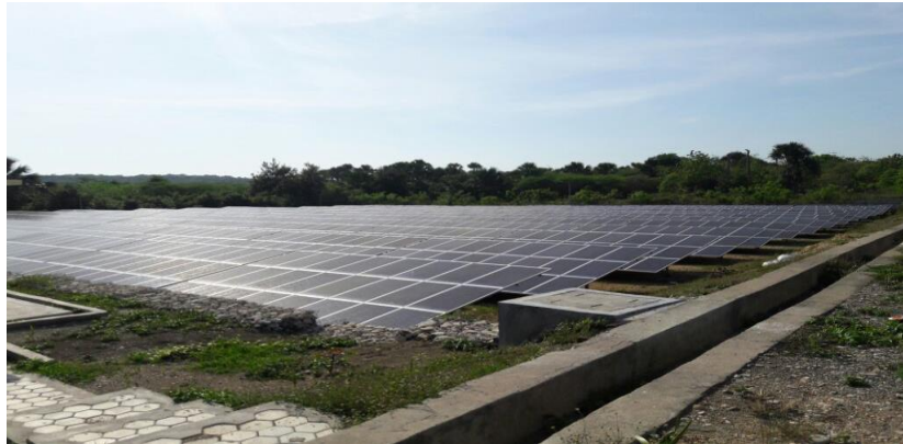
Gambar 2.9. Pembangunan Pembangkit Listrik Tenaga Surya (PLTS) di Provinsi NTT
